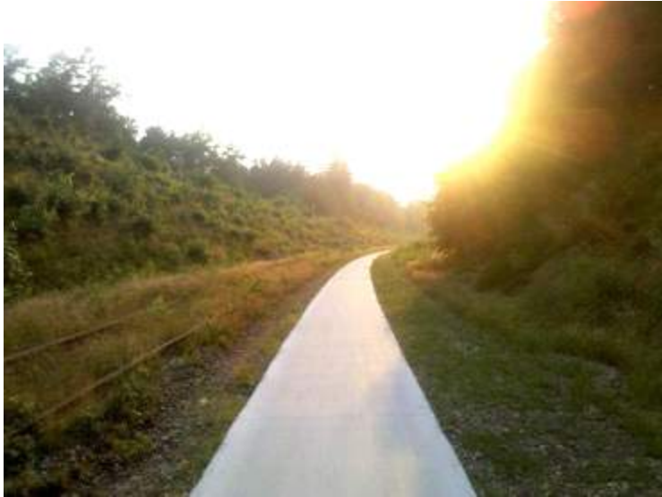
Figuur 1.1 Het fietspad in de spoorkuil kijkend richting Nijmegen (west). Aan de zuidzijde is de oude rails nog zichtbaar, aan de noordzijde het grind van het ballastbed.
